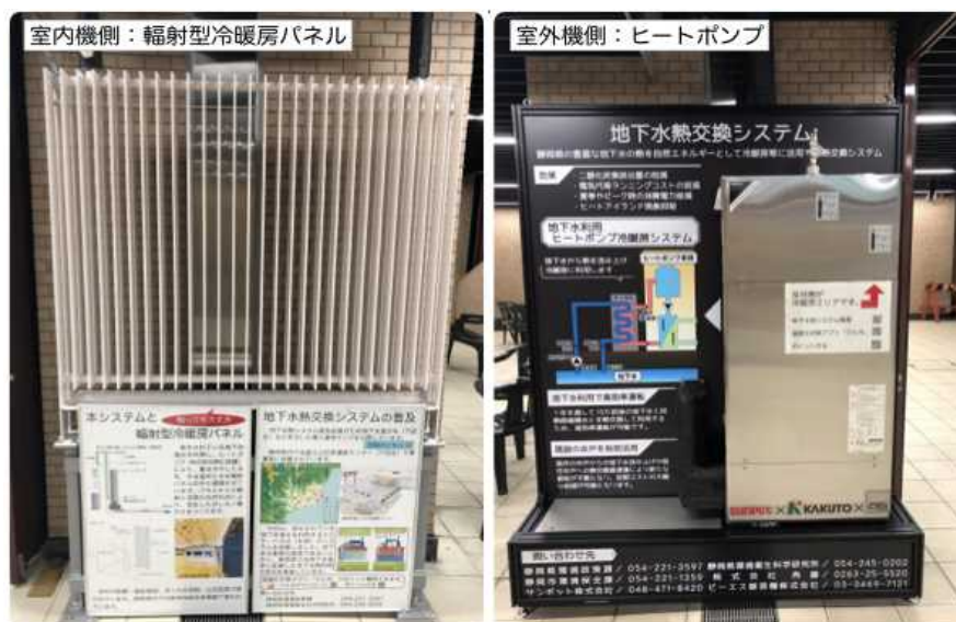
写真1 紺屋町地下街に設置した地下水熱交換システム
