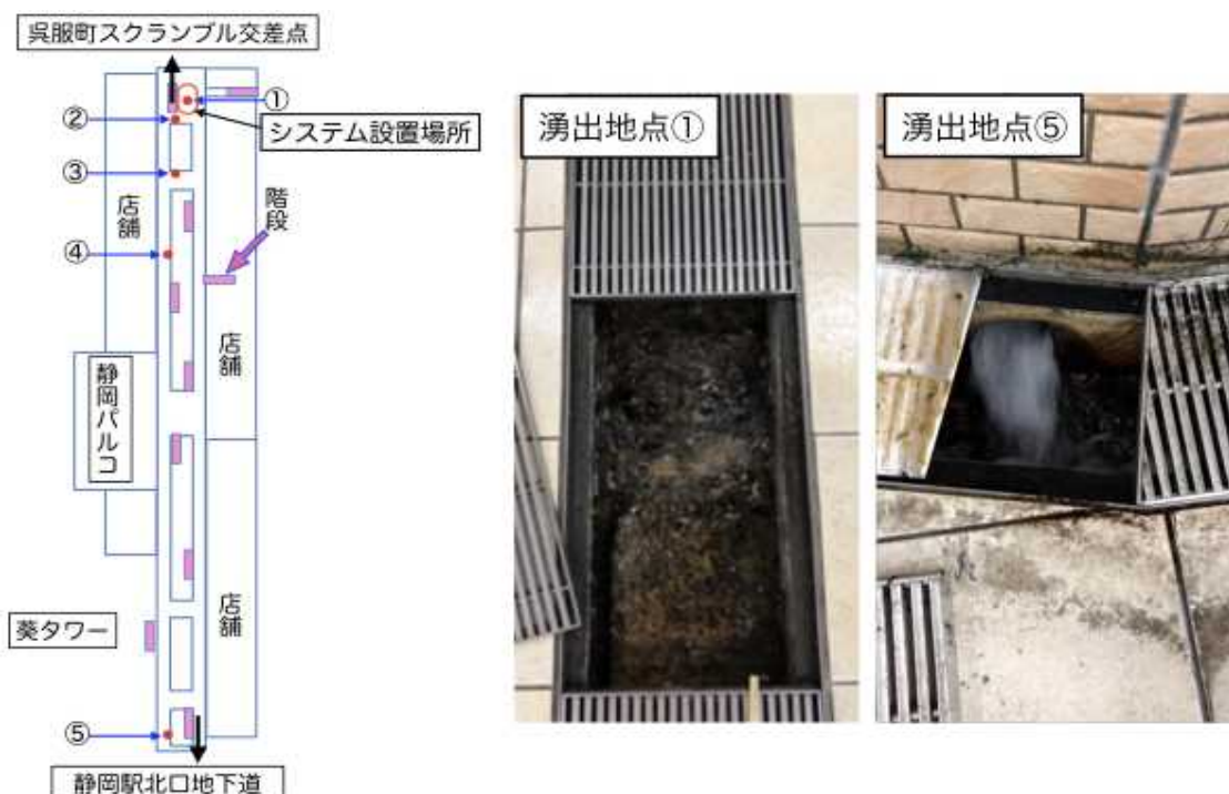
図1 紺屋町地下街において調査した地下水湧出地点（①～⑤）、システム設置場所および地下水湧出の様子
