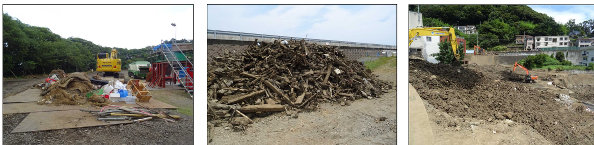
図3 現地での目視調査
